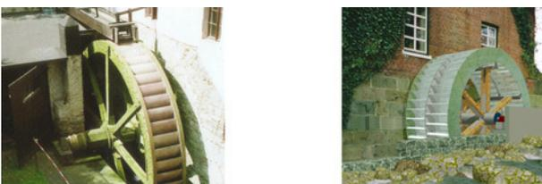
Abb. 1: Wasserrad oberschlächtig (li.) und mittelschlächtig (re.)<sup>3)</sup>
